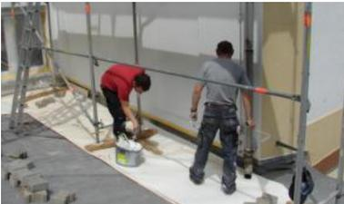
Neu und weiß strahlen jetzt die Turmrückseite und der Giebel über dem Küchenanbau. Die zugesetzten Fenster im Treppenhaus wurden außen verputzt – und weil der Mörtelkübel einmal auf dem Dach war, gleich noch die fehlenden Stellen an den Fenstern der
