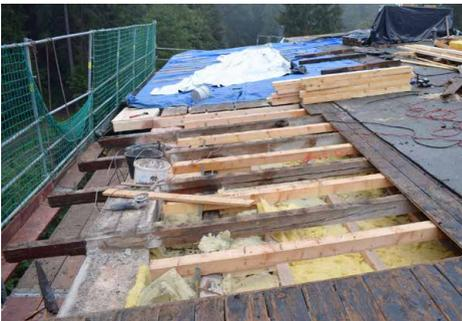
Nachdem der alte Dachbelag vom Hauptdach entfernt war, konnten wir den Dachüberstand erneuern und die kaputte Schalung wechseln. Dabei kam die nächste Überraschung. Die vorhandene Schalung war zu sehr zusammengetrocknet und dadurch für die Befestigung der Blechscharen zu dünn. Somit entschieden wir uns auf dem gesamten Hauptdach (über 600m<sup>2</sup>)
